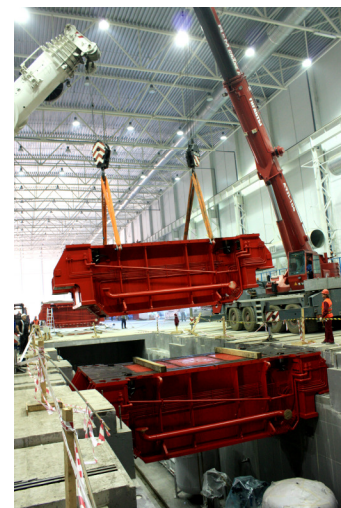
200-тонные передвижные краны во время монтажа
